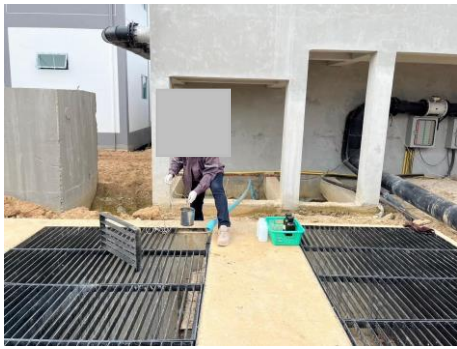
บ่อตรวจสอบสมบัติน้ำเสีย (Inspection Manhole) ของโรงงานที่อาจมีน้ำเสียเคมีปนเปื้อน
